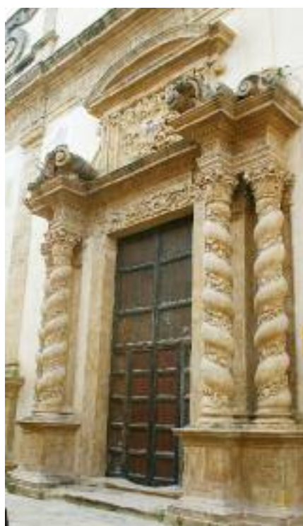
Nelle foto: la chiesa di Madonna dell'Alto a Mazara del Vallo; interventi sulla cupola della chiesa di San Giuseppe a Marsala. (foto Fontana) . Il portale della chiesa madre a Salemi (foto Firre) . Al centro del servizio d'apertura: il logo dell'Otto per mille della Cei.
